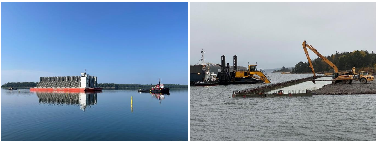
Stödmurselement anlände på pråm från Polen och är nu nedsänkta på havsbotten i nya kajläget.
