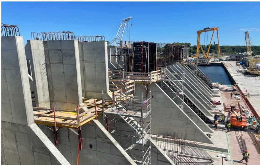
Stödmursegment på pråm i Polen i väntan på avfärd Hargshamn.
